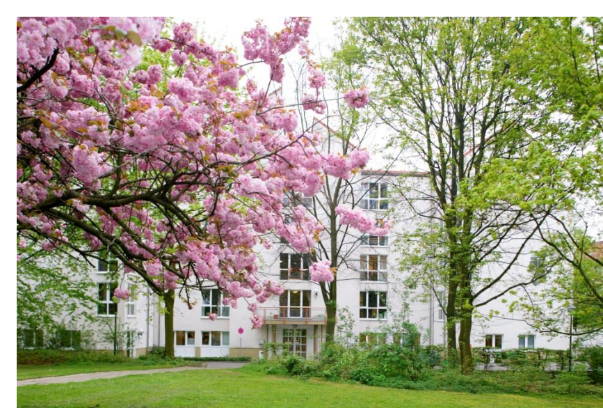
Foto: Ev. Johanneswerk
